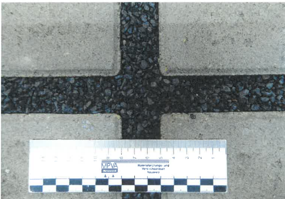
Bild 3: Resultierende Fugenbreite mit Fugenfüllung
