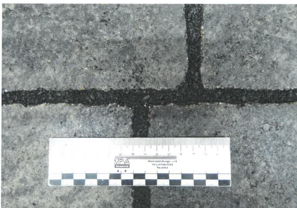
Bild 4: Resultierende Fugenbreite mit Fugenfüllung
