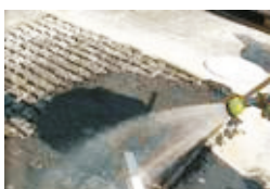
einkehren ggf. mit einem weichen Wasserstrahl unterstützen
