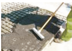
Diagonal zum Fugenverlauf einkehren
